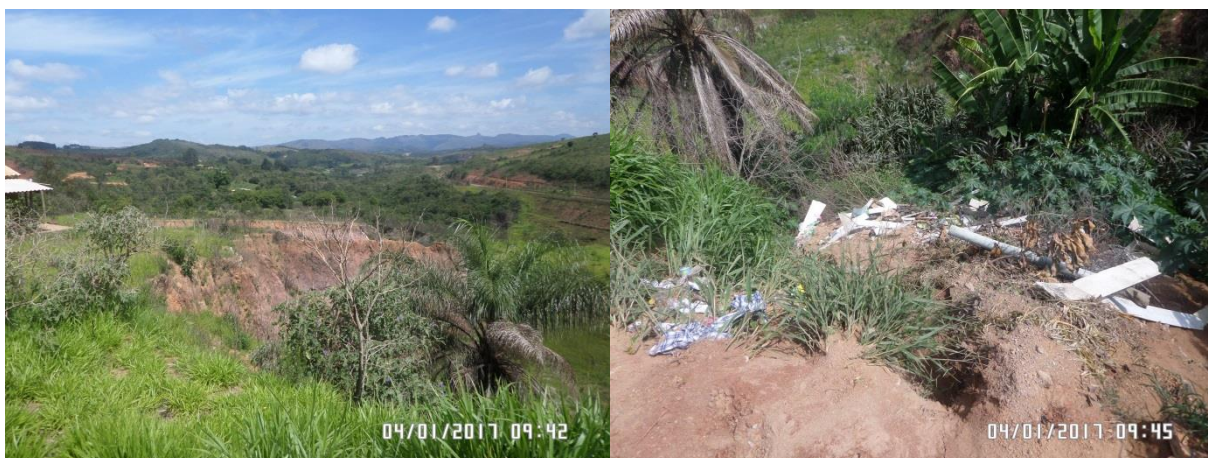
Figura 3.8 – Processos erosivos na sub-bacia do Ribeirão Carioca, em Itabirito-MG, devido ao escoamento superficial das águas da chuva (a); propiciando a instalação de bota-fora irregular de resíduos da construção civil (b)
